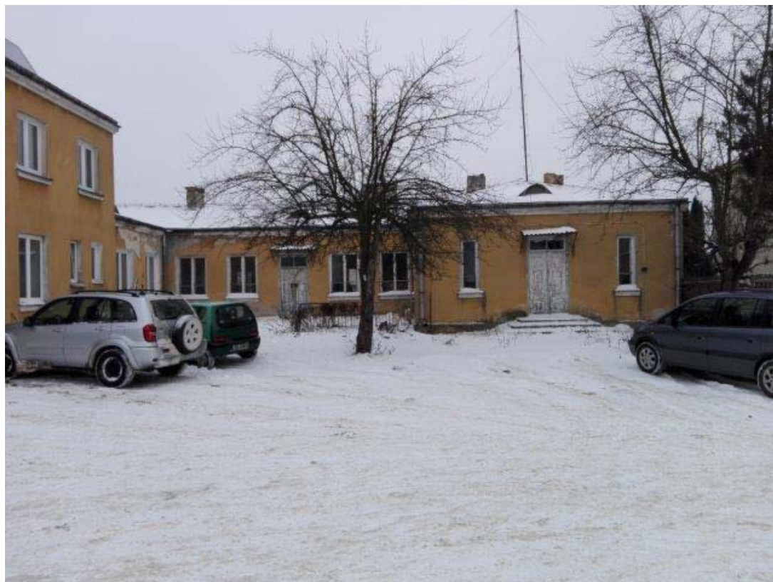
Ryc. nr 1 Budynek na ulicy Zamojskiej 13.
