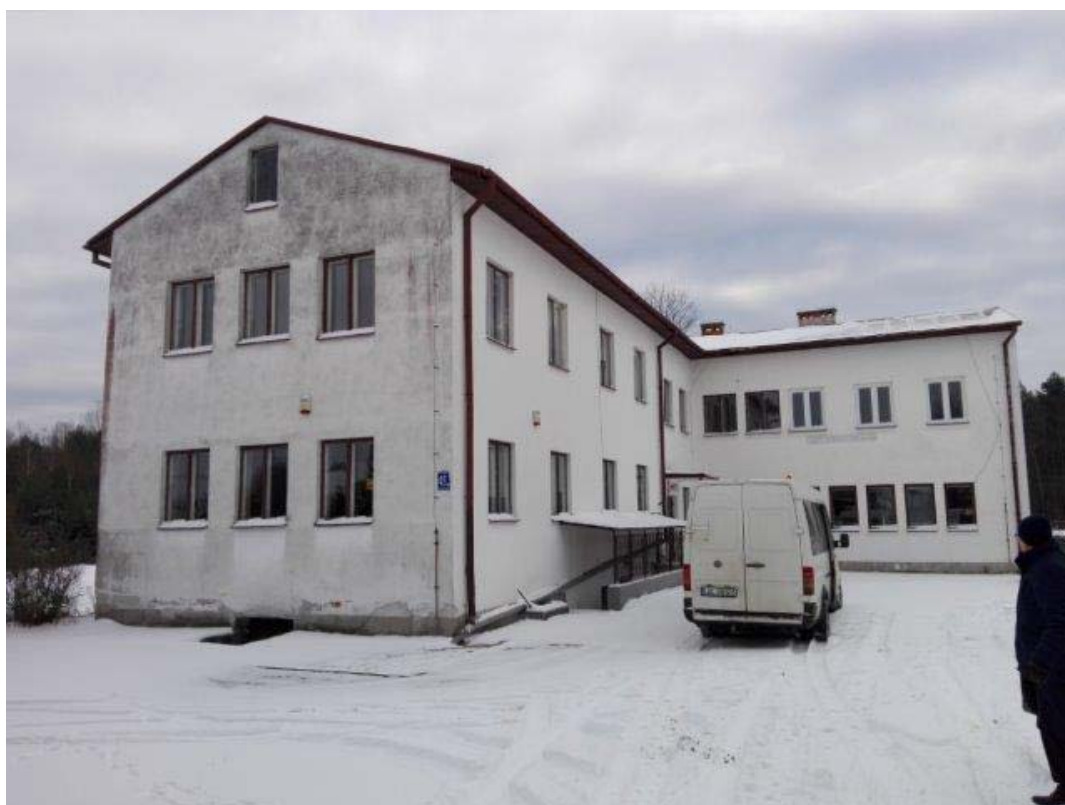
Ryc. nr 7 Budynek byłej szkoły w Korytkowie Małym.
